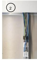
Messa a terra: collegare elettricamente il profilo esterno con il solo modulo connesso alla rete di alimentazione (con apposito cavo giallo/verde), mediante viti e rondelle date in dotazione (già avvitate sul modulo).
